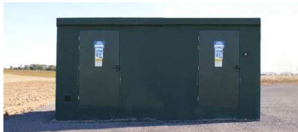
Figure 98 : Aperçu des locaux techniques
